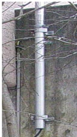
5. Koaxialkabel durch den vormontierten Antennenköcher schieben. Mastrohre auf den Köcher stecken und Flügelschraube an Mastbride festziehen.
