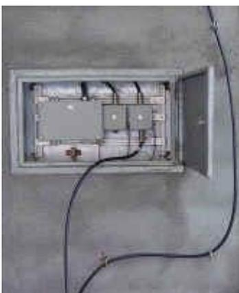
6. Koaxialkabel an der Antennenanschlussdose anschliessen.
